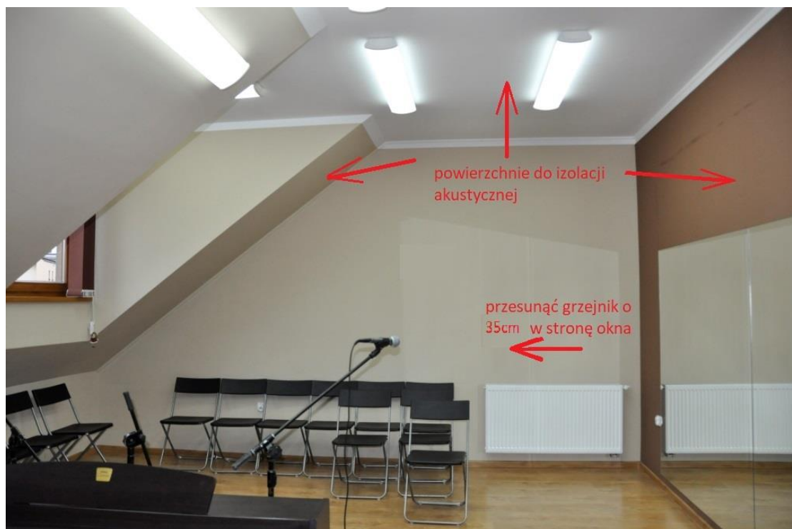
Rys.6. Ściana 3 z grzejnikiem do przesunięcia
